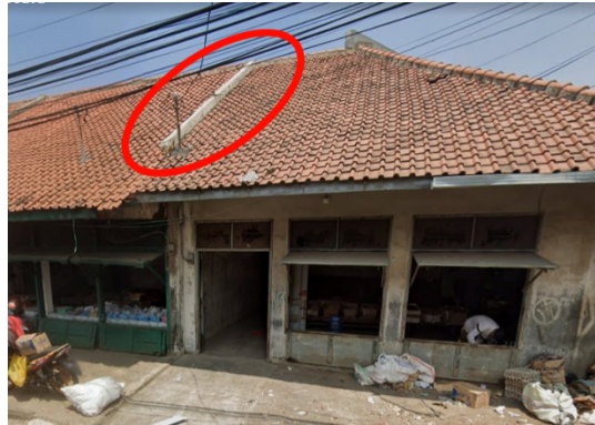
Gambar 7. Tembok Api Perbatasan Ruko Jap Loen
