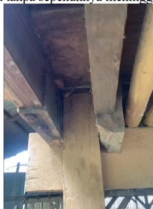
Gambar 12. Kai dengan metode sambungan kayu pada Sapu Tada
