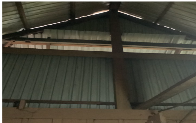
Gambar 7. Tuko yang menerus dari sandi hingga ke atap tanpa sambungan pada Sapo Tada
