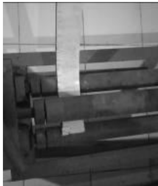
Gambar 4. Proses Bending ACP Sumber: Dokumentasi Pribadi 2019
