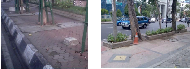
Gambar : rasa keamanan karena beda ketinggian dengan jalan 20 cm dan pot yang memisahkan dengan kendaraan bermotor.
