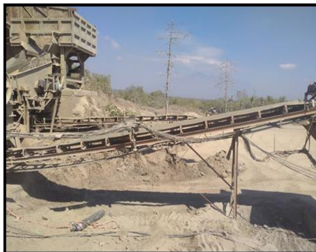
Gambar 3. Belt conveyor di lapangan
