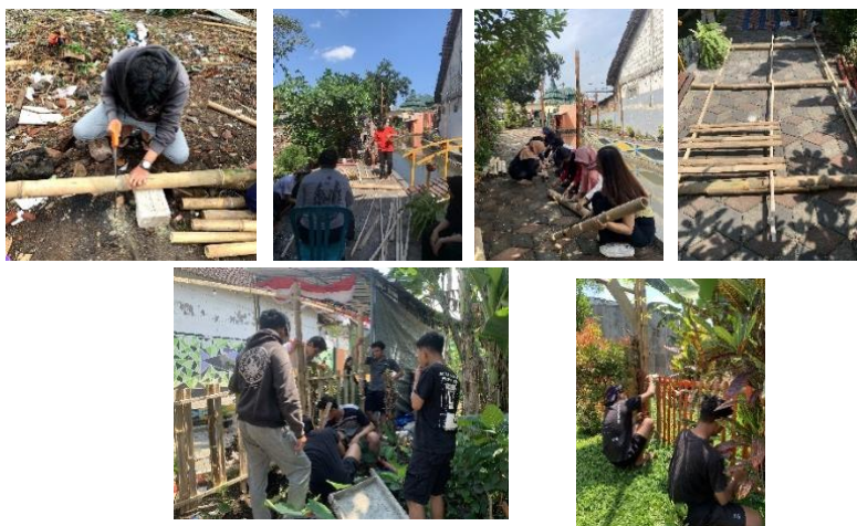
Gambar 4. Proses pembuatan pagar pembatas dan pagar tuntuk tanaman hias yang dilanjutkan dengan pemasangan dan pengecatan pagar
