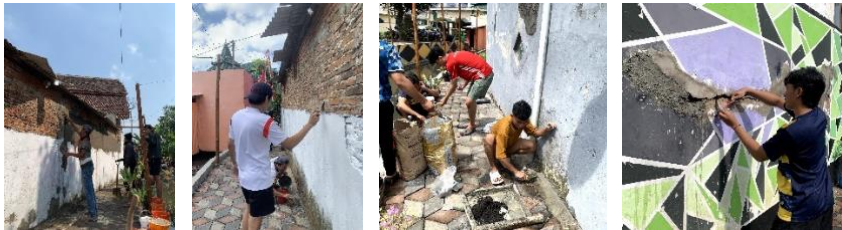
Gambar 2. Proses perataan permukaan dinding untuk mural
