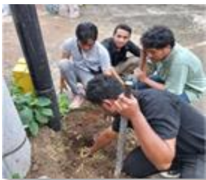
Gambar 7. Penggalian tanah untuk pondasi tiang bunga
