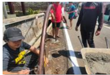
Gambar 8. Pengecoran tiang tanaman bunga
