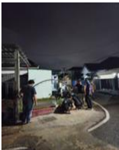
Gambar 10. Pemasangan tiang dengan cara di clamp
