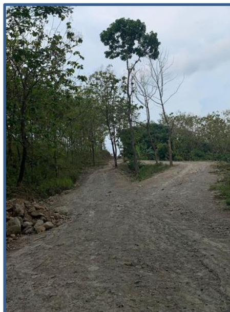
Gambar 7. Kondisi Jalan Tambang
