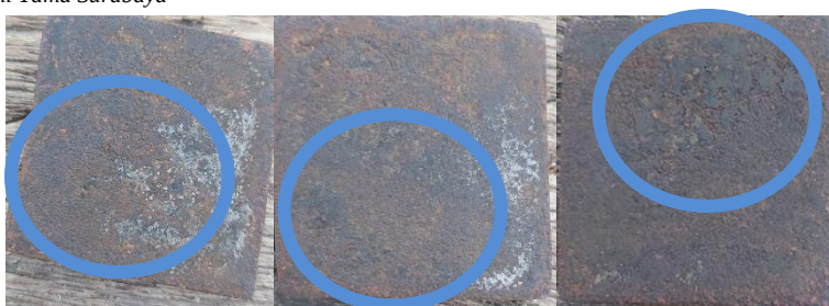
Gambar 4.2 Korosi yang terjadi pada sampel
