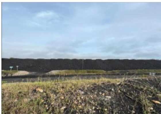
Gambar 4. Timbunan batubara pada area stockpile
