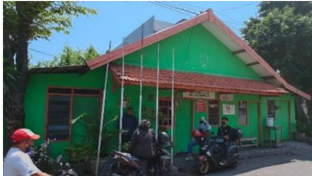
Gambar 1. Kondisi Eksisting Balai RT
