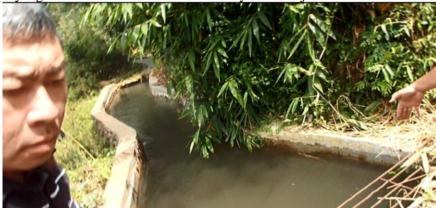
Gambar 2. Saluran masuk bak penenang 1 (existing)
