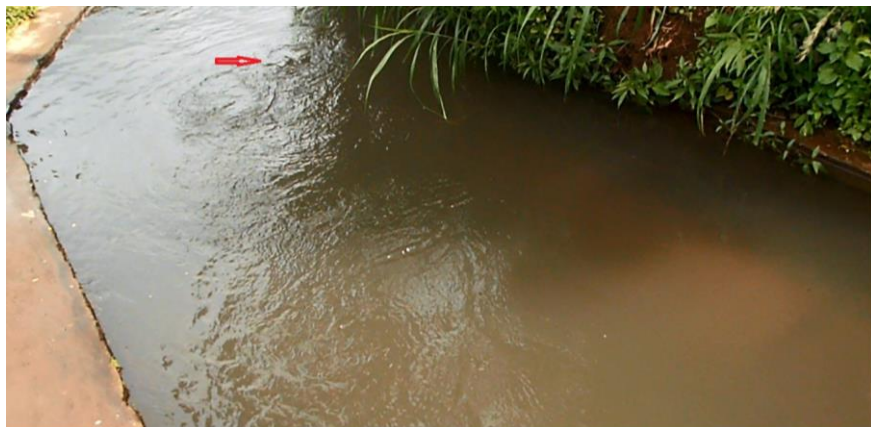
Gambar 3. Letak kebocoran pipa beton (arah panah)
