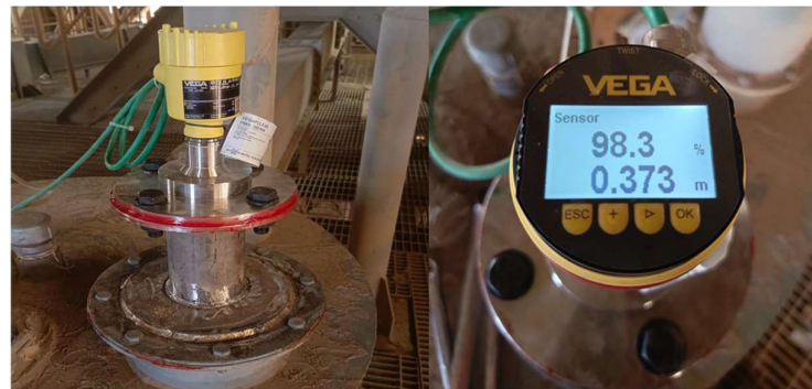
Gambar 6. Modifikasi Penggantian Sensor Radar untuk level Pengukuran Bin (Sumber: Dokumentasi Pribadi)
