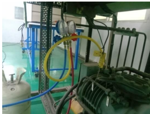
Gambar 5. Proses Pengisian Sistem dengan Refrigerant R-134a
