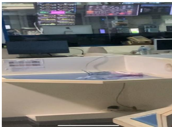
Gambar 2 Proses pengerjaan crimping yang telah selesai
