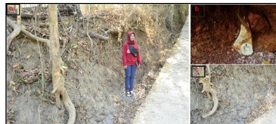
Gambar 4. a. Singkapan batuan Andesit daerah Gunung Cakaran b. Litologi Andesit c. Kenampakan Kekar (Shear joint) pada Lokasi pengamatan 1
