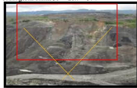
Gambar 9: Longsor Lowwall pada Panel A
