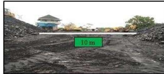
Gambar 8: Lebar Jalan pada Dua Timbunan
