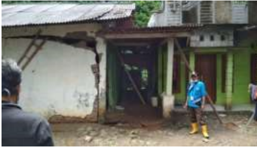
Gambar 5: Pondasi rumah ambles dan dinding retak pada rumah warga di Desa Tumanggal-Pengadegan.
