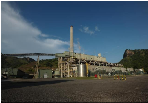
Gambar 2: PLTU milik PT AMNT di area pelabuhan Benete (Sumber : PT AMNT, 2019)
