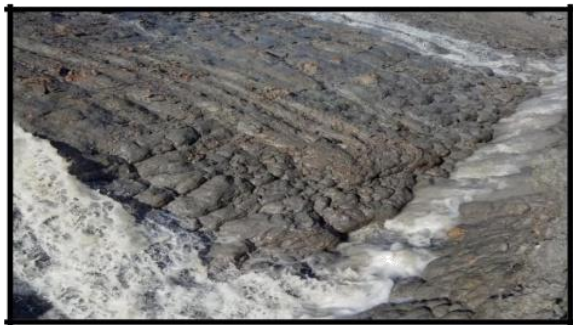
Gambar 3: Kondisi sumuran bawah PIT 1
