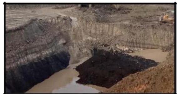
Gambar 6: Kondisi saluran terbuka 1
