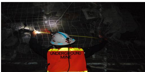
Gambar 7: Aktual spasi cable bolt dan ring 602 Conveyor GBC PT. Freeport Indonesia
