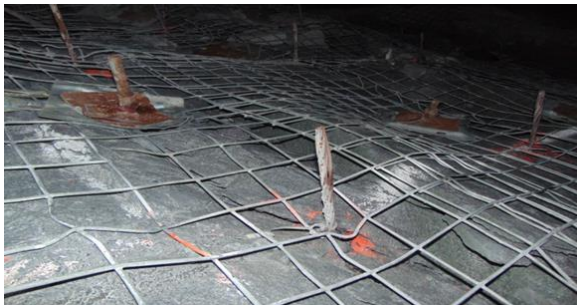
Gambar 5: Aktual spasi cable bolt dan ring 602 Tail GBC PT. Freeport Indonesia
