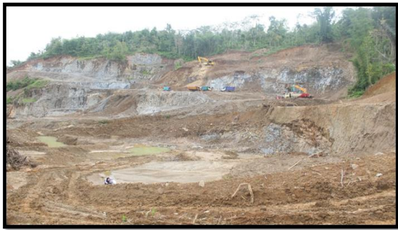
Gambar 3: Kondisi Lahan yang Sudah Dilakukan Penambangan
