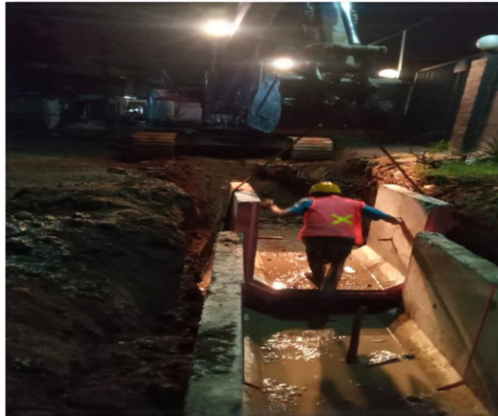
Gambar 3.1 Perencanaan Drainase (Sumber : Dokumentasi Kerja Praktek 2023)
