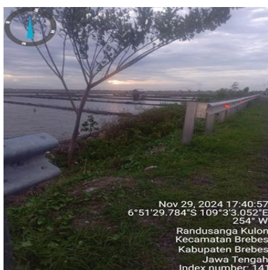
Gambar 6 Pengaman Samping Yang Terpotong Gambar 7 Pengaman Samping Hanya Satu Sisi
