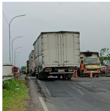
Gambar 3 Kerusakan Tambalan Pada Jembatan
