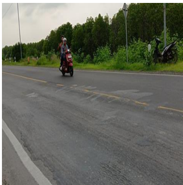
Gambar 2 Kerusakan Jalan Alur ( Rutting )
