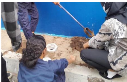
Gambar 3. Proses Pembuatan Teknologi Biopori
