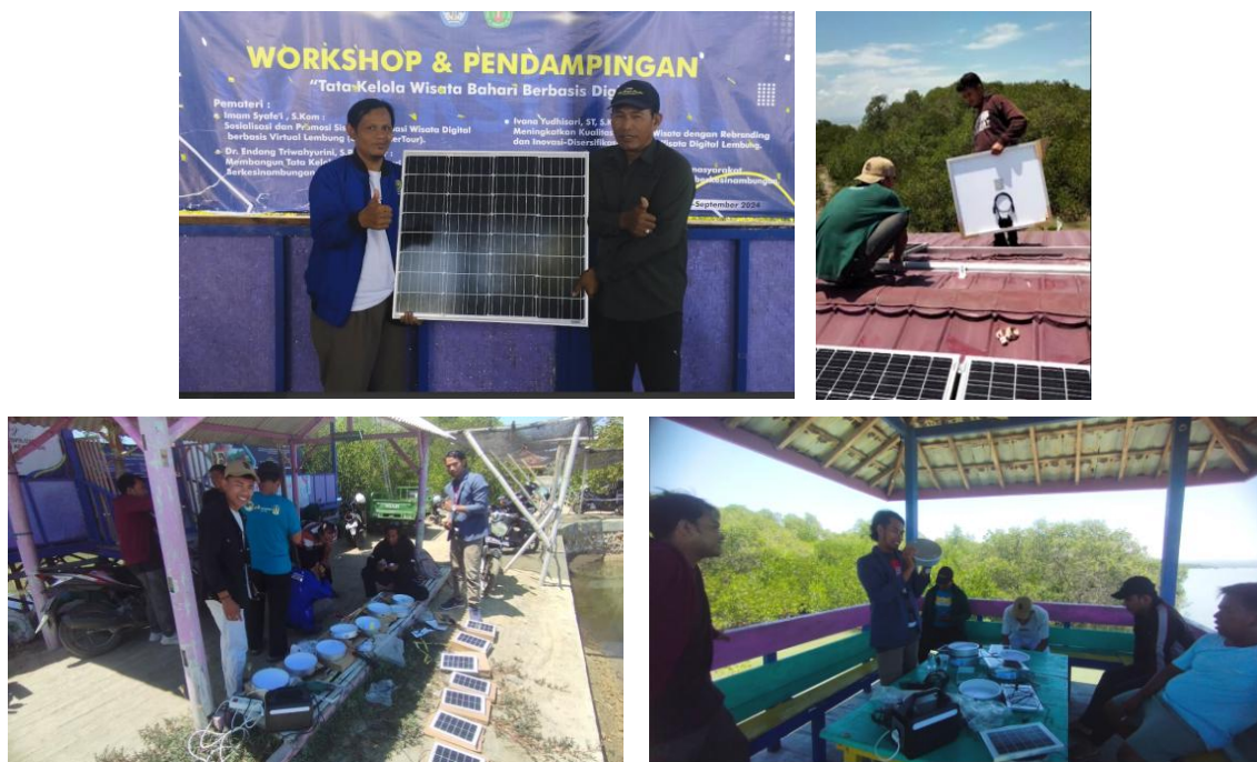
Gambar 3. Pemasangan PLTS 600 WP, September 2024
