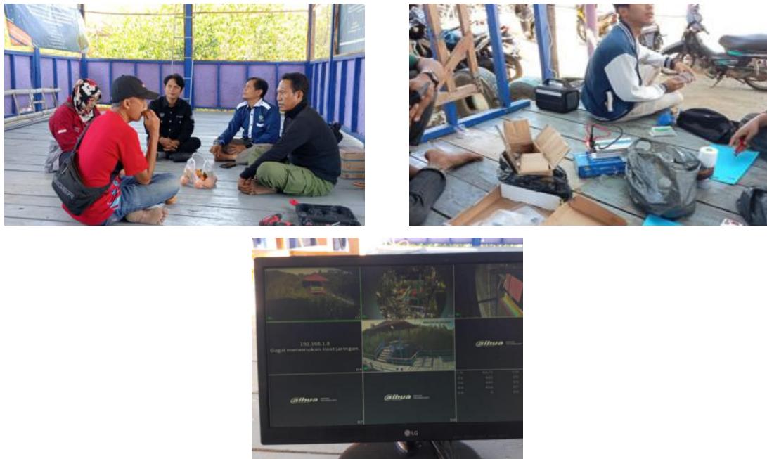
Gambar 4. Pemasangan 10 Titik CCTV
