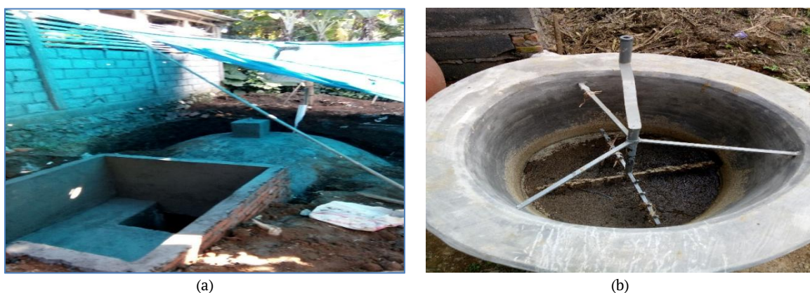
Gambar 5. Digester Fixed Dome : (a) Pembangunan Digester Sudah Selesai dan Siap Digunakan; (b) Silinder dengan Bahan Cor Dilengkapi dengan Alat Pengaduk.
