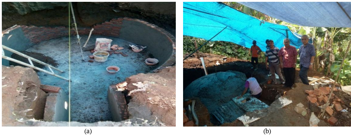
Gambar 4. Proses Pembangunan Digester : (a) Pembangunan Dasar dan Dinding Digester ; (b) Pembangunan Dome Digester .
