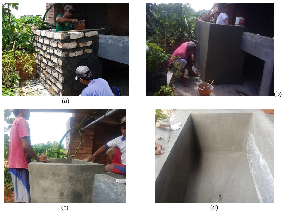
Gambar 6. Pekerjaan bangunan bak koagulasi (a) Pemasangan batu bata dinding, (b) Plester dinding, (c) Penghalusan (aci) dinding, (d) Bangunan bak selesai
