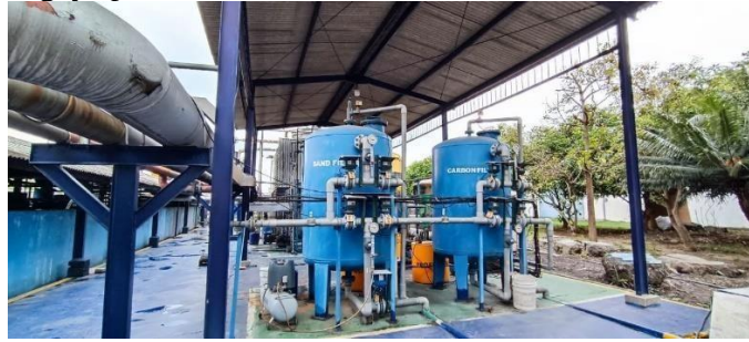
Gambar 4. Alat penjernihan air sumur menggunakan sand filter dan carbon filter
