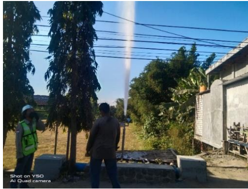
Gambar 4. Pelaksanaan Hydrottest di lokasi pekerjaan
