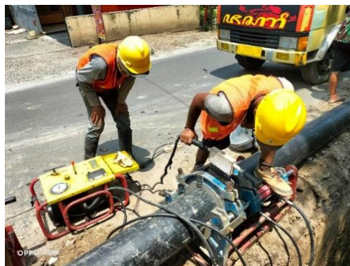
Gambar 2. Penyambungan Pipa HDPE
