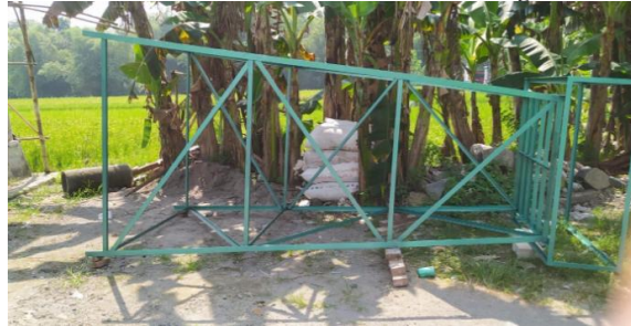
Gambar 4. Tampak samping menara air sebelum dipasang.
