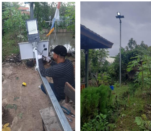
Gambar 4. Tahap Pemasangan Lampu PJU Solar cell
