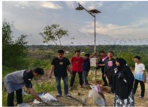
Gambar 7. Pemasangan dan pengecoran tiang PDU.
