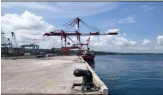
Gambar 1: Pelabuhan Tenau Kupang.
