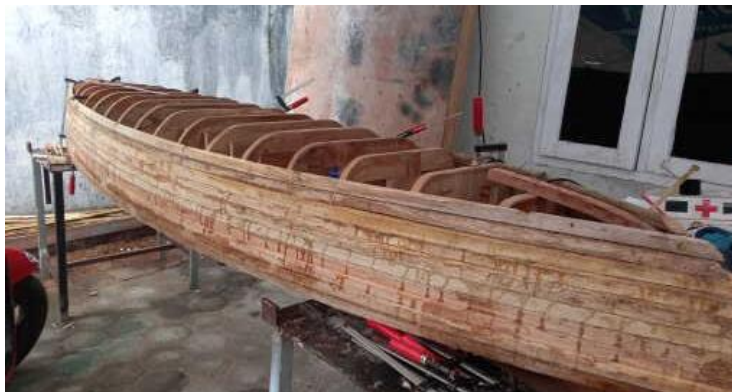
Gambar 4. Pemasangan Kulit Perahu
