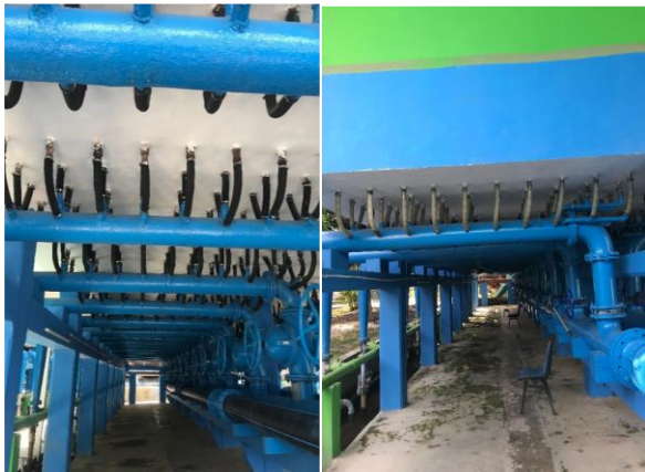
Sistem Underdrain Saringan Pasir Cepat IPA Ngagel I
